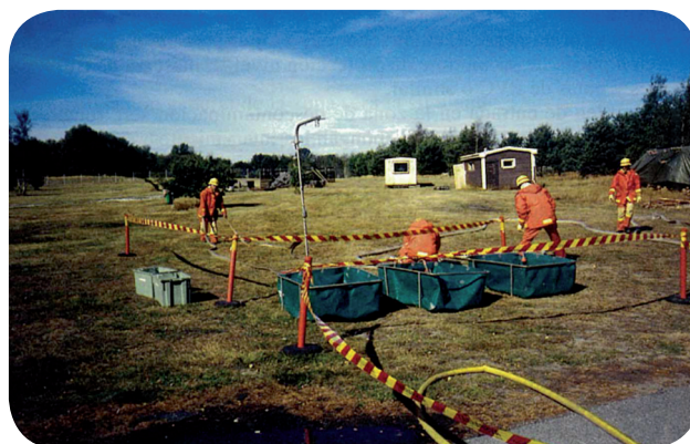
Salida de la zona de descontaminación. Se aprecian cajas para herramientas contaminadas, ducha y zonas de limpieza.
